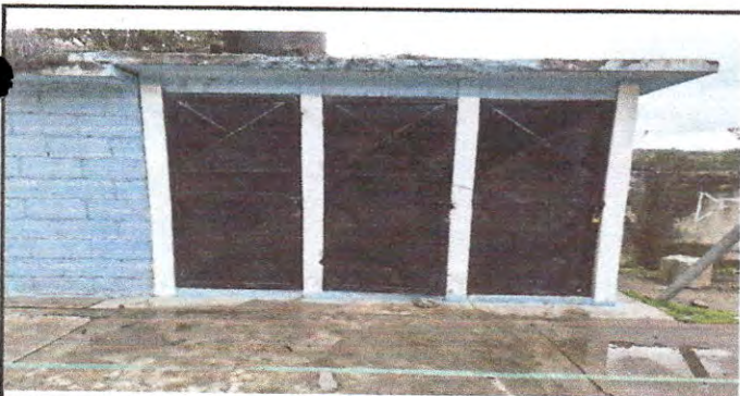
Foto 5: en esta foto se observa las puertas que fueron sustituidas de del servicio sanitario de 6 mts cuadrados
