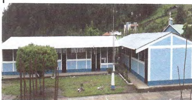
Foto 2: En la se observa la lámina del techo que fue sustituido por lámina troquelada aluzinc calibre 26 que será de 279.50 mts cuadrados y en modulo que se pinto la lámina
