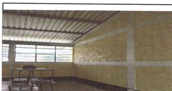
Foto 6: En esta foto se observa la parte interior de techo de la escuela que se sustituyeron las existentes por láminas troqueladas aluxinc Calibre 26
