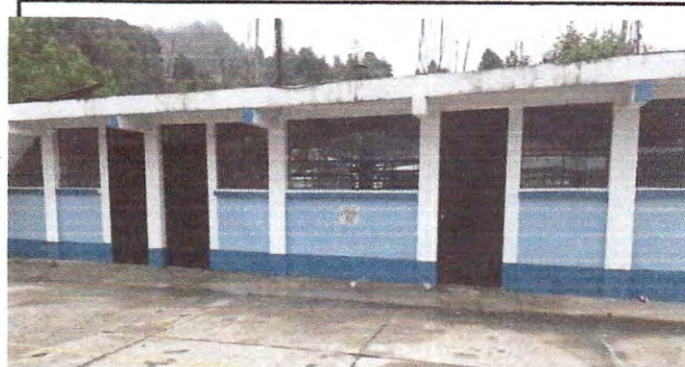
Foto 4: En la foto se observa las puertas a que se sustituyeron
