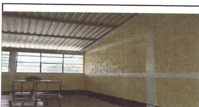
Foto 6: En esta foto se observa la parte interior de techo de la escuela que se sustituyeron las existentes por láminas troqueladas aluxinc Calibre 26
