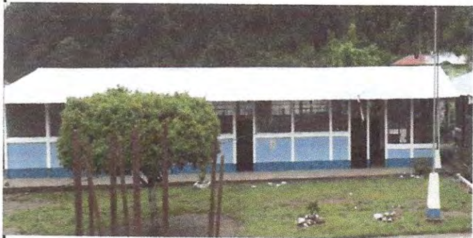
Foto 1: En la foto se observa el frente del centro educativo ya instalada la lámina troquelada aluzinc calibre 26
